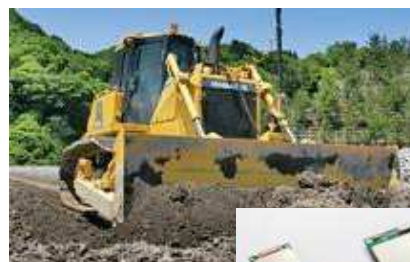
GNSSシステムブルドーザ
