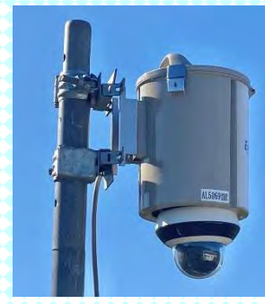
③ 2個目の単管用取付金具を取り付け、両方のボルトを固定する
